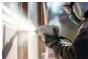
Arenado para decapado
